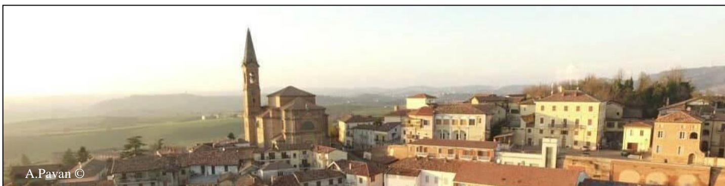
Tonco visto dal drone
